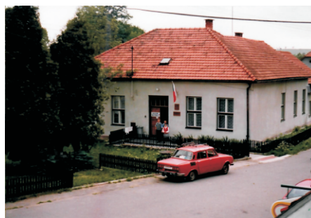
Budova obecního úřadu, č.p. 5
