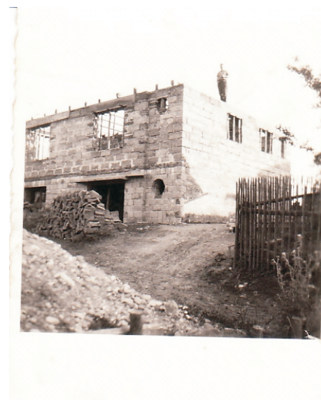
Dům č.p. 66 stavba
