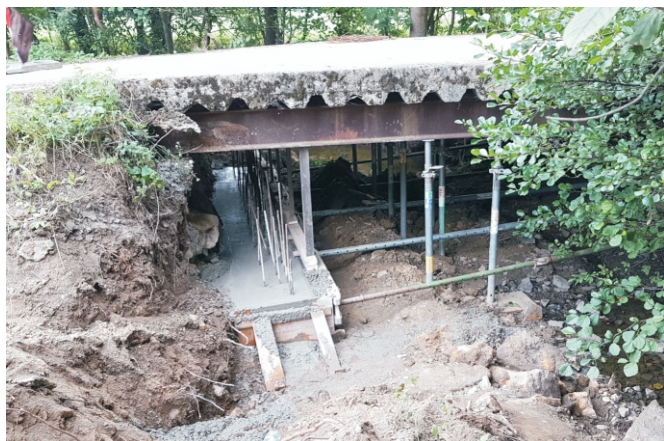
most po opravě
