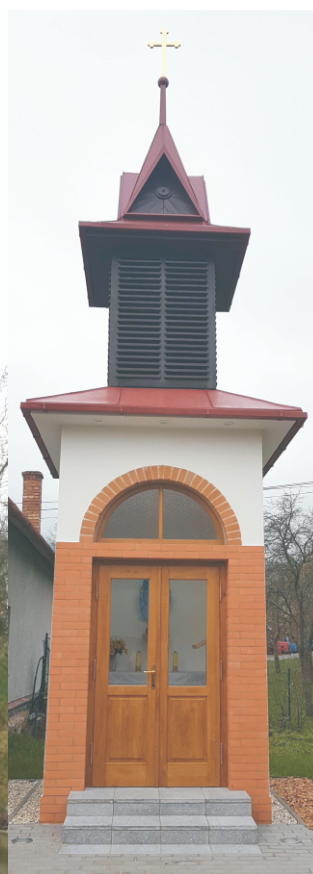
kaple po opravě
